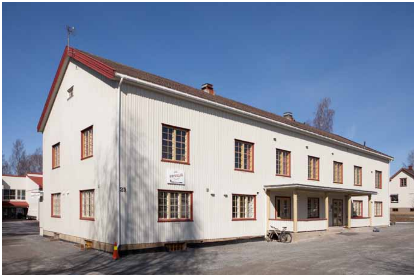
Bøndernes Hus på Løten, tegnet av funksionarkitekten Finn Poppe i 1930-årene, var like ved å bli revet. Nå en restaurert praktbygning og et synlig bevis på Sjur Harbys mangesidige virksomhet.
